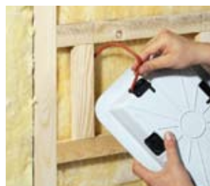
Mit innenliegendem Wechsel. Montage avant pare-vapeur.
